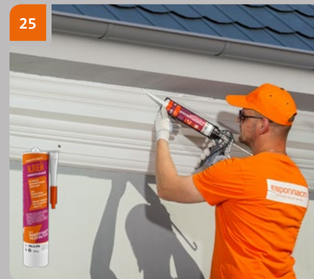
Заполнить клеем места примыкания изделия к поверхности на тех участках, где клей не выступил.
