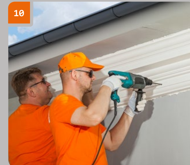
10 При помощи перфоратора, сделать отверстия для крепления изделия дюбель-гвоздями с шагом ≈600 мм.
