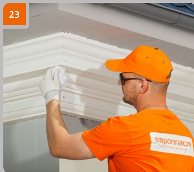
Протереть стык тканью, смоченной ацетоном.
