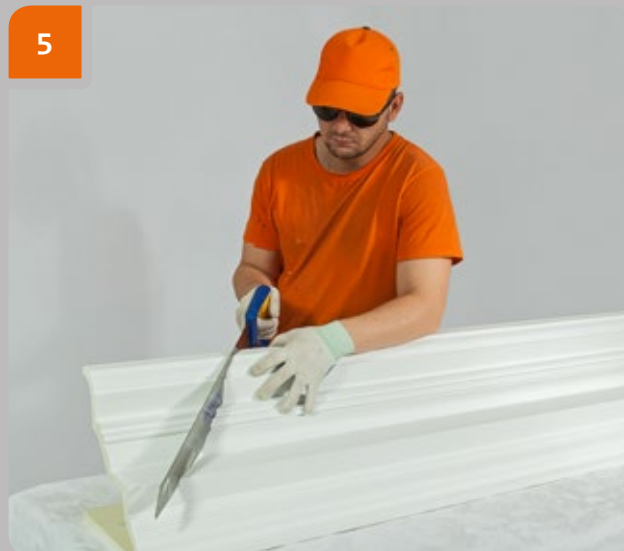
5 С помощью ножовки завершить распил.
