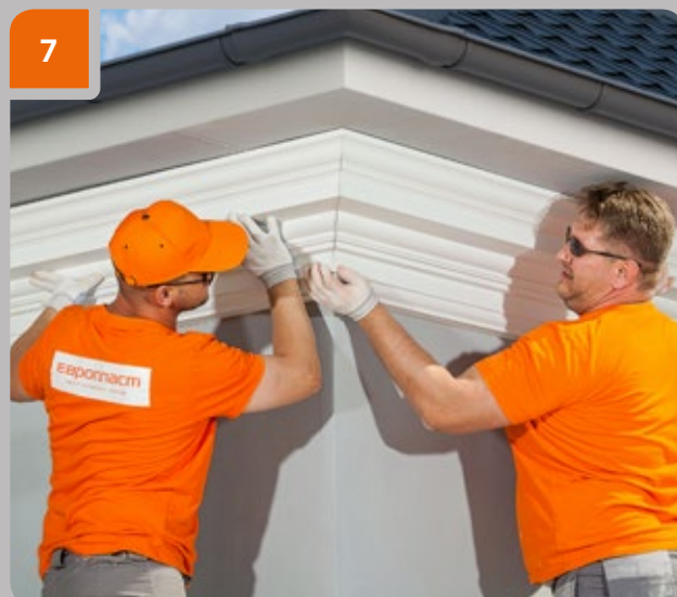
7 Проверить совмещение рисунка и профиля изделий.
