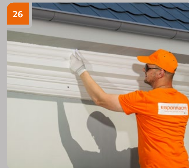
Удалить излишки клея тканью, смоченной ацетоном.
